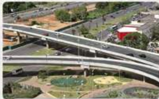
NOVOS VIADUTOS PARALELA
