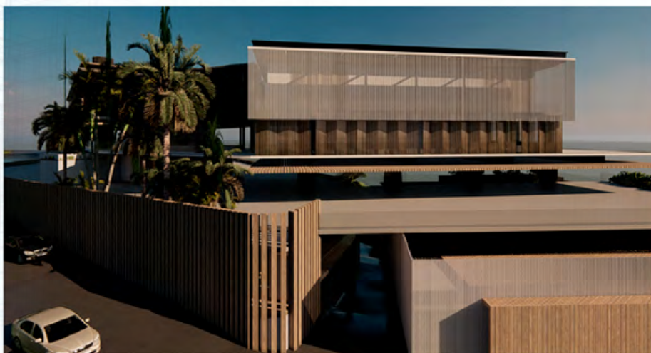
Imagem 13: Acesso da Garagem e Auditório
