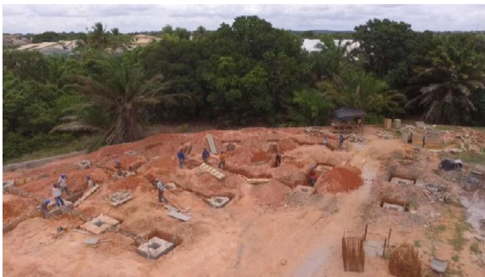
Figura 2 - Monitoramento dos funcionários no canteiro
