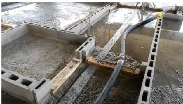
**Figura 14** - Instalação exposta após a execução do contrapiso (Obra B)
