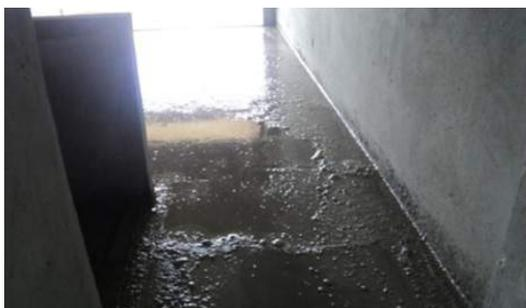
A logística do sistema foi a mesma para todas as obras. O preparo da base, que consistia em varrição, aspersão de água para remoção de impurezas e para saturação da base para recebimento da argamassa, fixação das tubulações e colocação das barreiras, ficava a cargo da própria empresa. A figura 13 mostra as barreiras colocadas na obra A. A Figura 14 mostra uma tubulação que, por não ter sido fixada adequadamente, ficou exposta após o endurecimento da argamassa, ocasionando em retrabalho.
