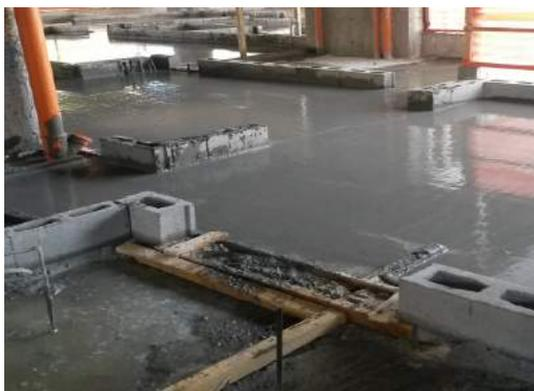
**Figura 12** – Argamassa após o lançamento (obra B) apresenta exsudação
